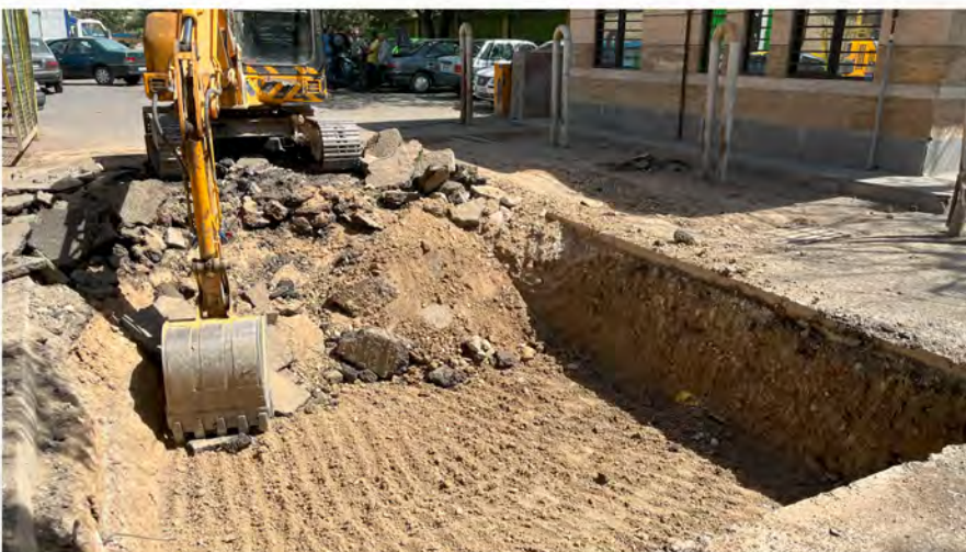
- عملیات عمرانی خاکبرداری
