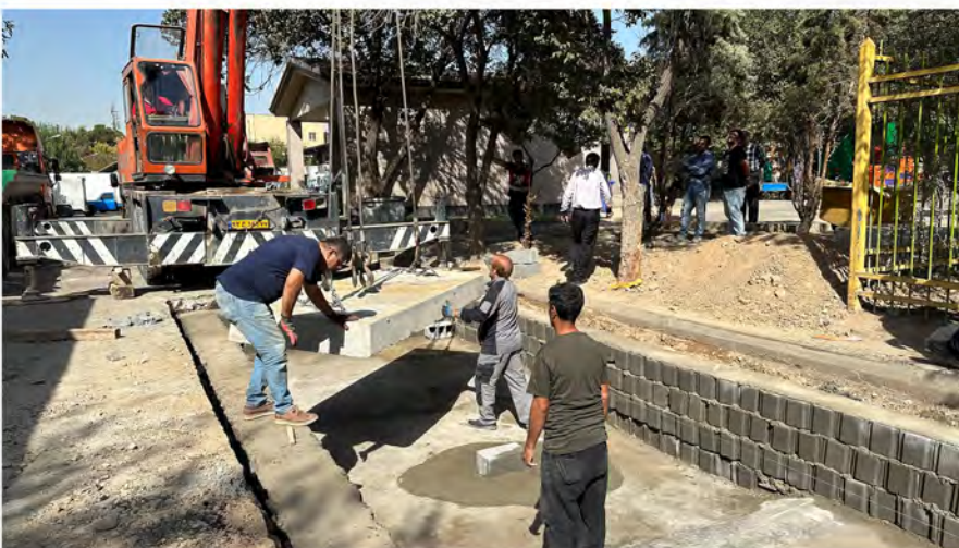
- نصب فونداسیون پیش ساخته
