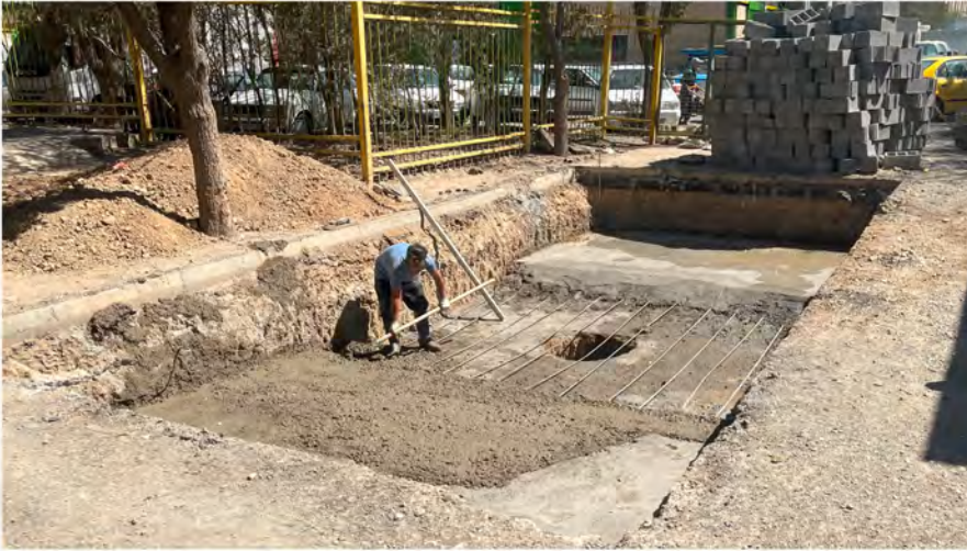
- اجرای بتن مگر و چاه فاضلاب
