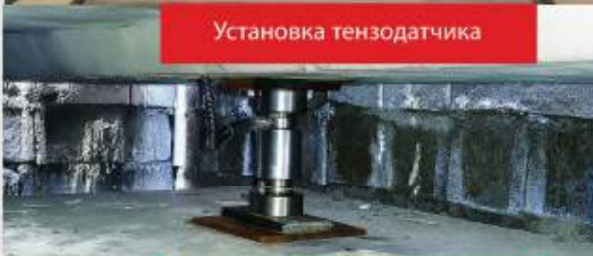
Монтаж и настройка весов
